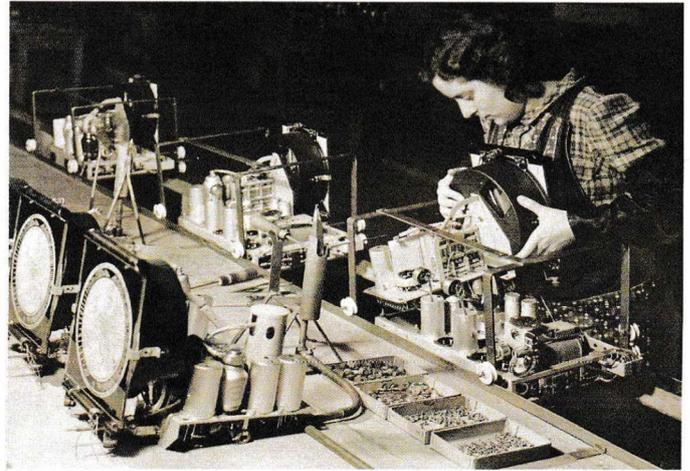
Einsetzen der fertig montierten Skalentrommel in das Gerätechassis. Man sieht von außen nur noch die (äußere) Lampenführungstrommel. Durch die rechteckige Öffnung auf der Rückseite konnte man die drei Lämpchen für die Lichtmarken bequem erreichen und austauschen.
